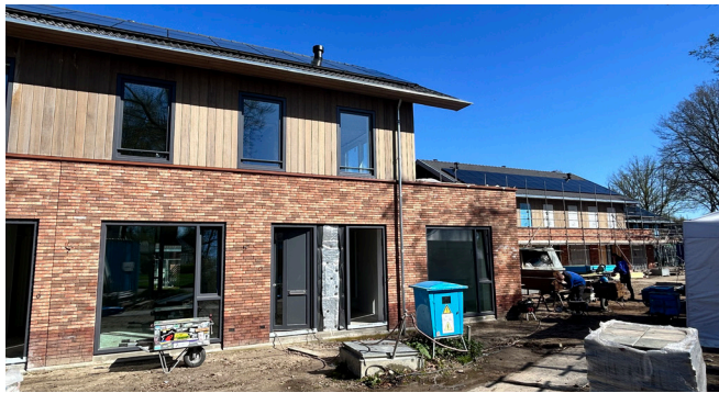
Nieuwbouw fase 2 – boven- en benedenwoningen (in aanbouw)
