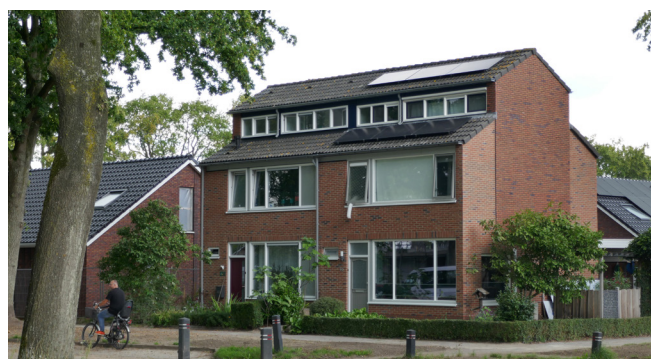
Renovatie twee-onder-één-kapwoningen Dingspelstraat
